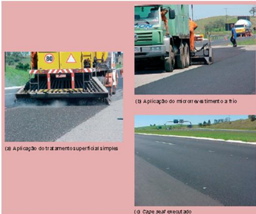
Figura 38 - Etapas da execução de cape seal
