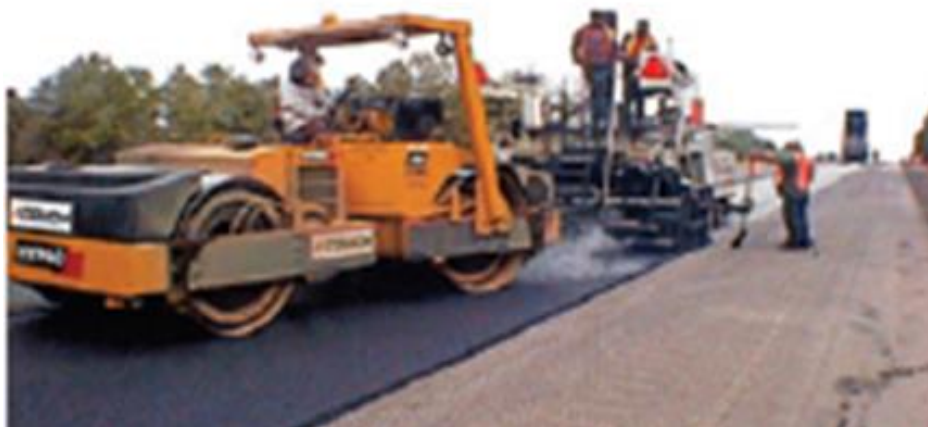
Figura 26 - Exemplo de rolo vibratório
