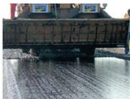
(d) Detalhe da distribuição de agregado
