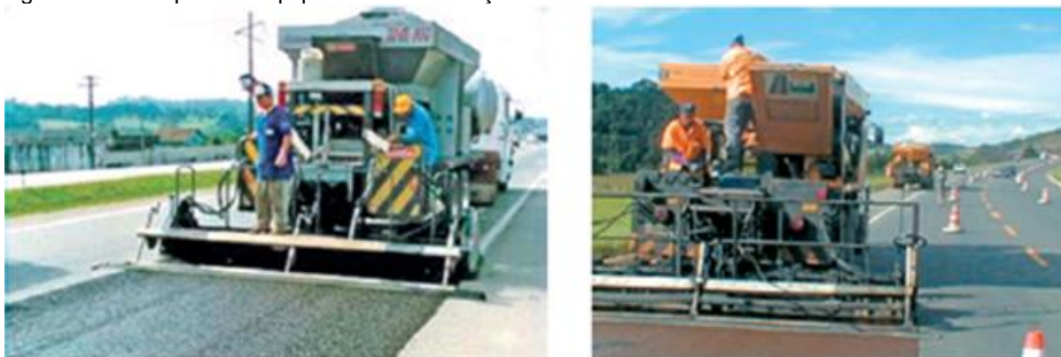
Figura 37: Exemplos de equipamento e execução de microrrevestimento a frio
