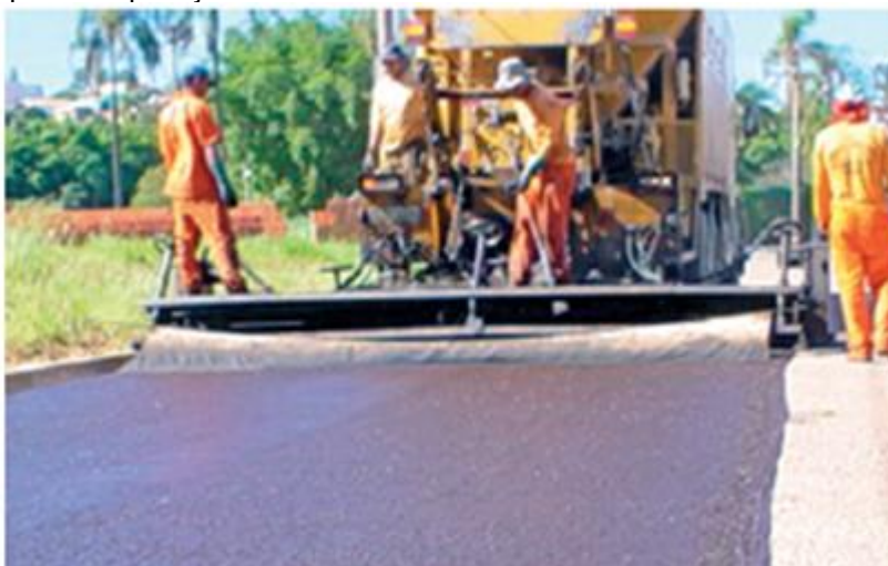
Figura 36 - Exemplos de aplicação de lama asfáltica
