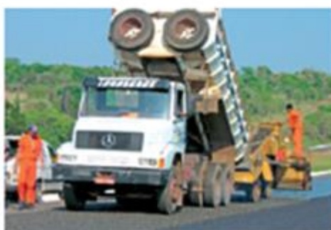
(c) Distribuição de camada de agregado
